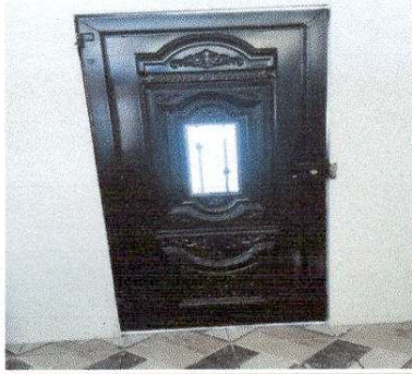
Foto 3: 4.3 Sustitución de Puerta en cocina
