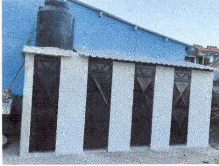
Foto1: 2.2 Sustitución de Estructura de Madera por Metal en sanitarios
