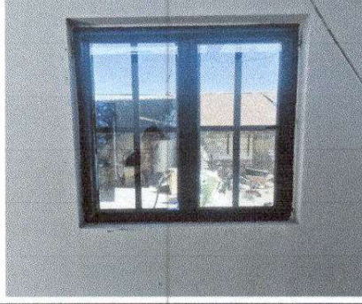
Foto 4: 5.3 Sustitución de ventana en cocina
